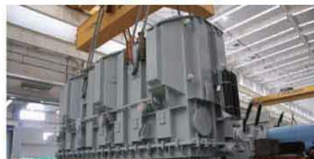
Пуэрто-Рико: трансформатор USA230kV 570MVA
